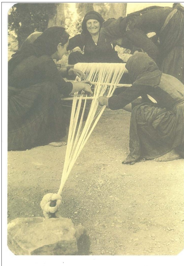
Εικόνα 28. Το τύλιγμα των βροχίδων του νήματος στο αντί, για να ακολουθήσει το μελώνιασμα στα μιτάρια. Μια δουλειά πολύ εκλεπτυσμένη και εγκεφαλική, η οποία απαιτούσε αυτοσυγκέντρωση, αλλά και εμπειρία, ώστε να ακολουθήσει το επόμενο στάδιο, το μελώνιασμα στα μιτάρια.
